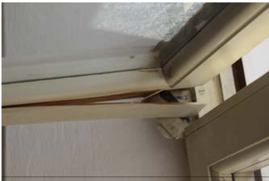
Ecco come si sono danneggiate le finestre delle salette di catechismo dopo il tremendo botto che ha provocato vari danni alle abitazioni vicine al luogo dello scoppio. Molte finestre hanno avuto i vetri rotti, altre invece si sono sbriciate in più punti.
