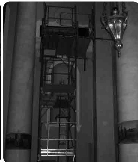
Una delle due uscite dell'aria calda installate nella sacrestia (che altrimenti rimaneva al freddo) e l'impalcatura eretta per modificare il foro di uscita dell'aria all'interno della chiesa: alcuni elementi visibili di un enorme lavoro che rimane nascosto ma di cui speriamo di sentire subito i benefici.
